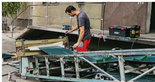
• Posledná kontrola PVC pásu pred zváraním.
