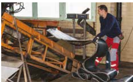
2. Z dopravníka demontujeme starý pás.
