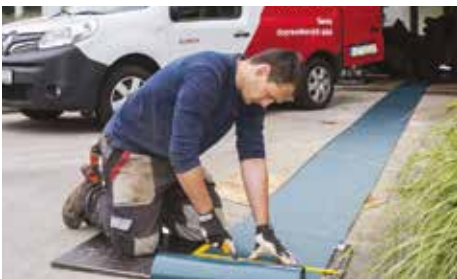
4. Vymeriame nový pás, zarežeme ho na požadovanú dĺžku do pravého uhla.
