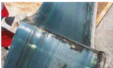
1. Kontrolujeme poškodenie pôvodného dopravníkového pásu.
